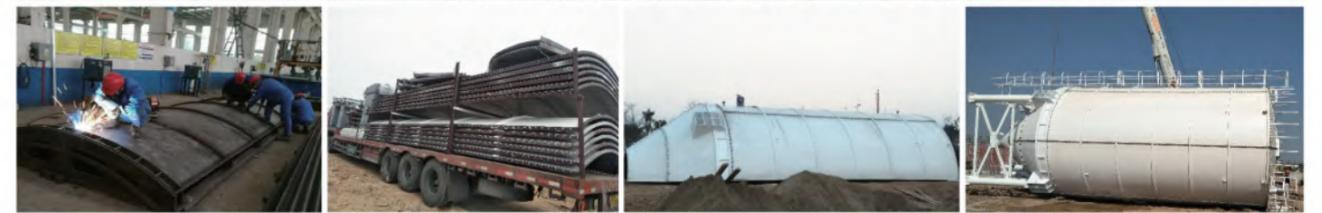
快装式组合仓解决了大吨位水泥仓的安装工艺复杂问题，有更好的结构强度和密封性能，提高了安装效率和可靠性，实现工厂化生产，利于环保
