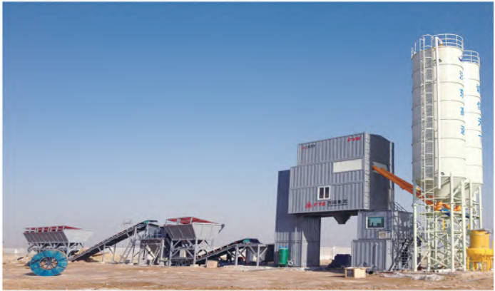
▲ 浙东高速施工现场
